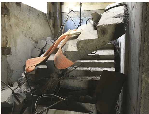
Рис. 65. Падение лестничного марша при выполнении строительно-монтажных работ по монтажу железобетонных конструкций (лестничного марша) со стропов башенного крана в г. Якутске
