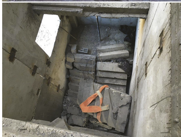
Рис. 65. Падение лестничного марша при выполнении строительно-монтажных работ по монтажу железобетонных конструкций (лестничного марша) со стропов башенного крана в г. Якутске
