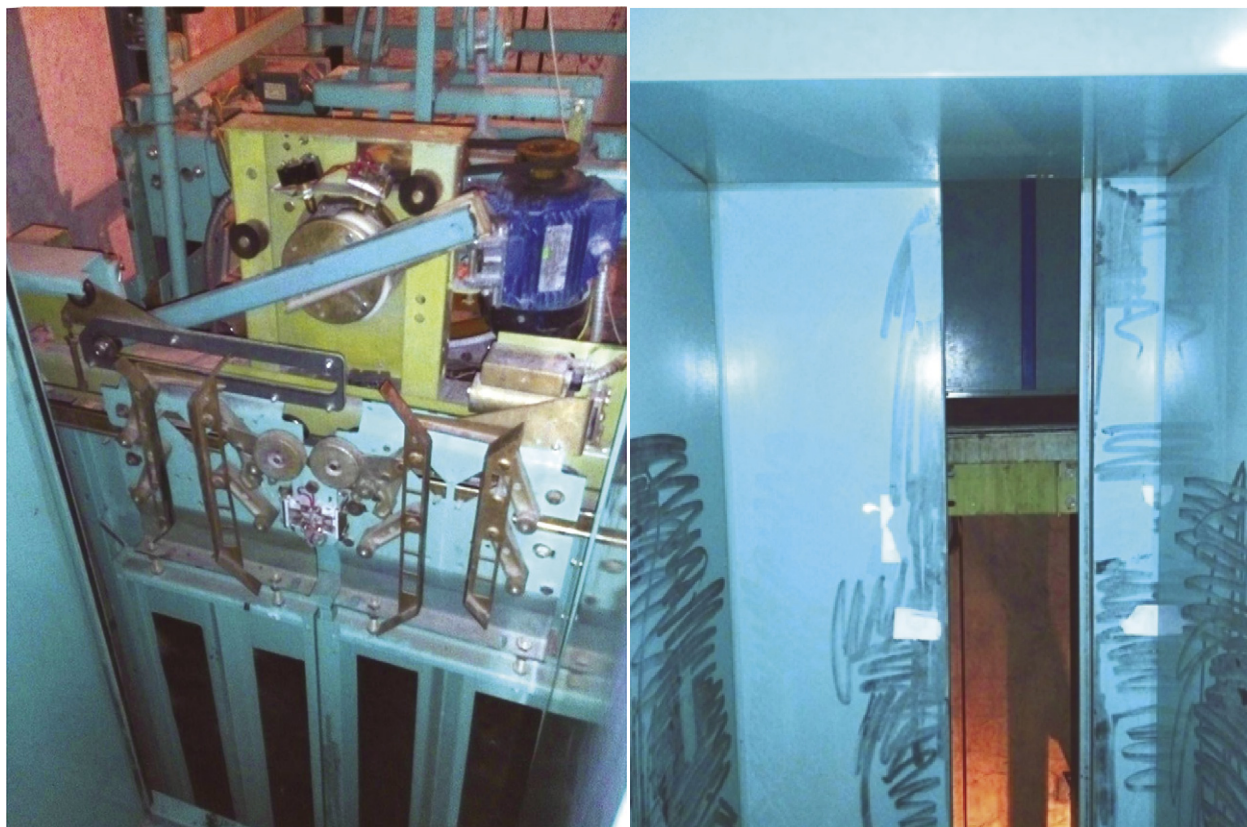
Рис. 70. Аварийная остановка лифта и последующее падение одного из пассажиров в шахту лифта при попытке самостоятельно выбраться
